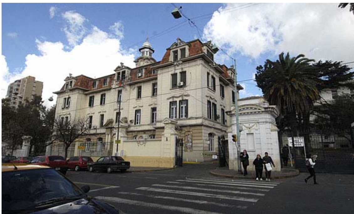
Acceso principal por Avenida Varela.
